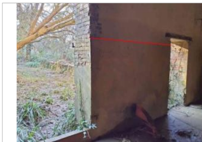
Vue du repère - Photo © AGERIN
