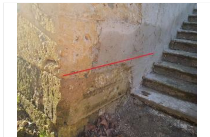
Vue du repère - Photo © AGERIN
