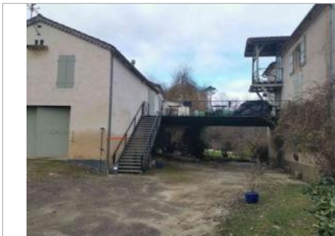
Vue du site - Photo © AGERIN
