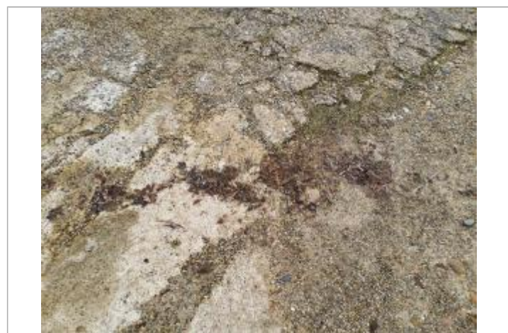
Vue du repère - Photo © AGERIN
