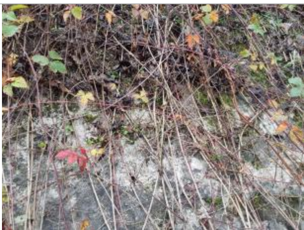
Vue du repère - Photo © AGERIN
