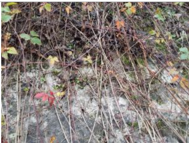
Vue du repère - Photo © AGERIN
