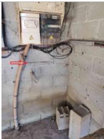
Vue du repère - Photo © AGERIN
