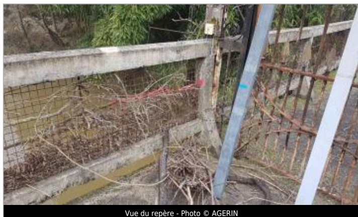
Vue du repère - Photo © AGERIN
