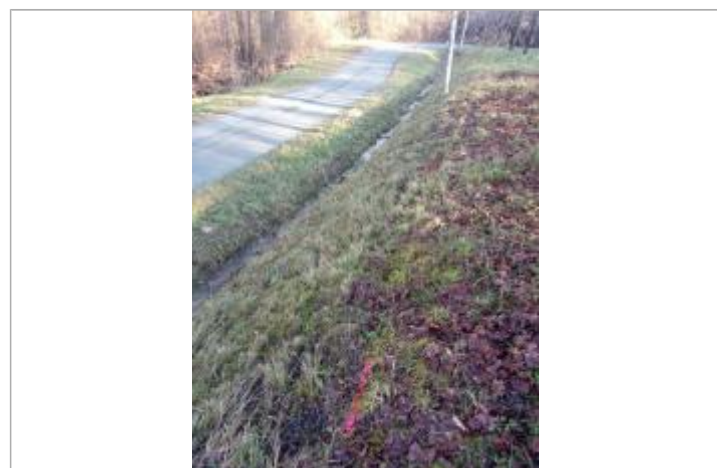
Vue du repère - Photo © AGERIN
