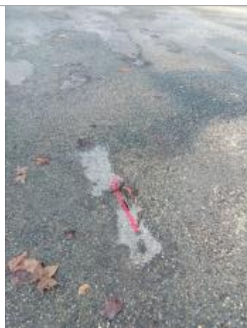
Vue du repère - Photo © AGERIN
