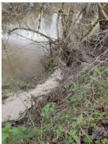
Vue du repère - Photo © AGERIN
