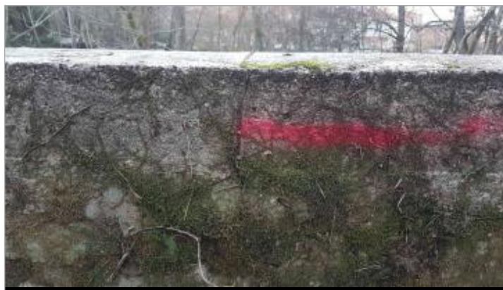
Vue du repère - Photo © AGERIN
