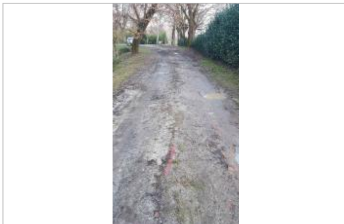
Vue du site - Photo © AGERIN
