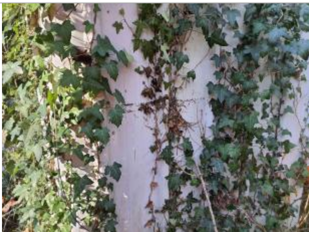
Vue du repère - Photo © AGERIN
