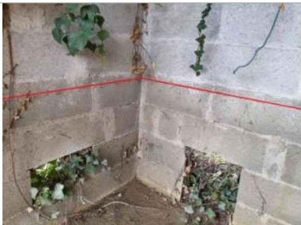
Vue du repère - Photo © AGERIN
