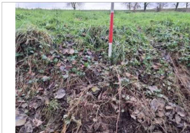
Vue du repère - Photo © AGERIN
