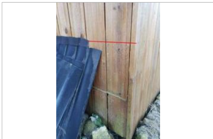
Vue du repère - Photo © AGERIN
