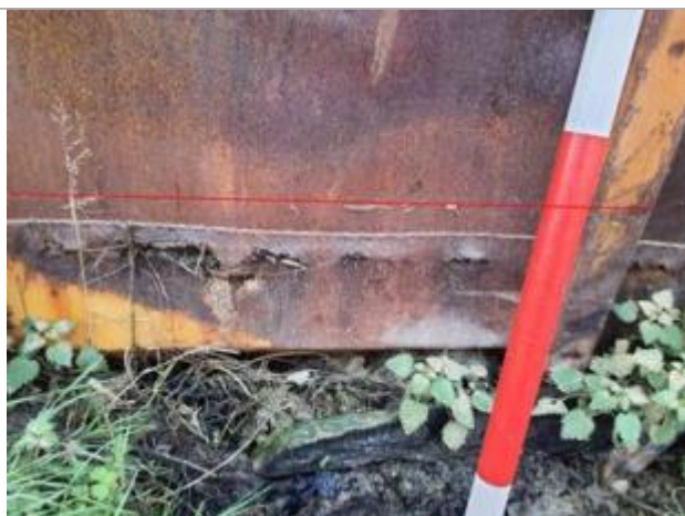
Vue du repère - Photo © AGERIN
