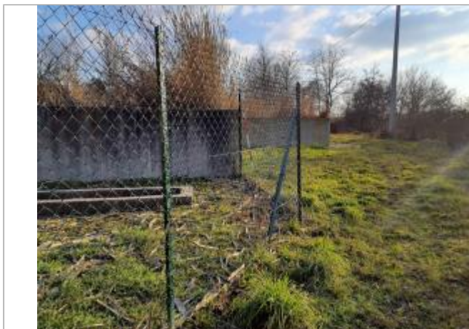
Vue du site - Photo © AGERIN
