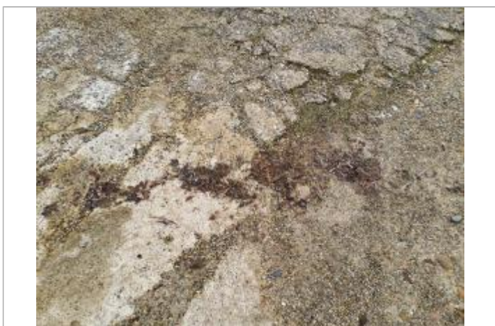
Vue du repère - Photo © AGERIN
