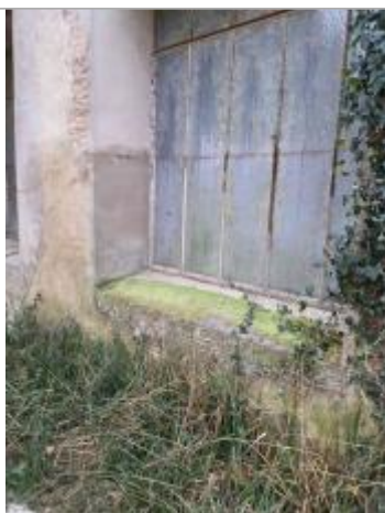
Vue du repère - Photo © AGERIN
