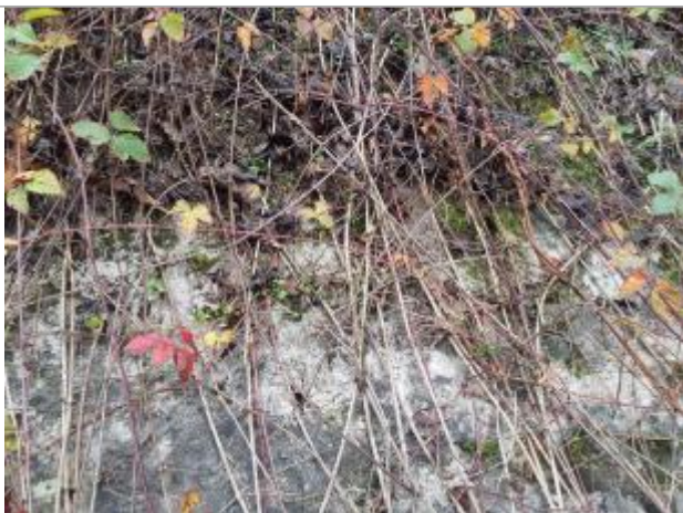
Vue du repère - Photo © AGERIN
