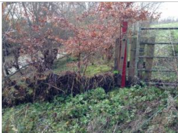
Vue du repère - Photo ©AGERIN
