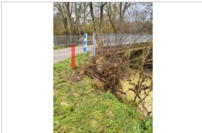
Vue du site - Photo ©AGERIN
