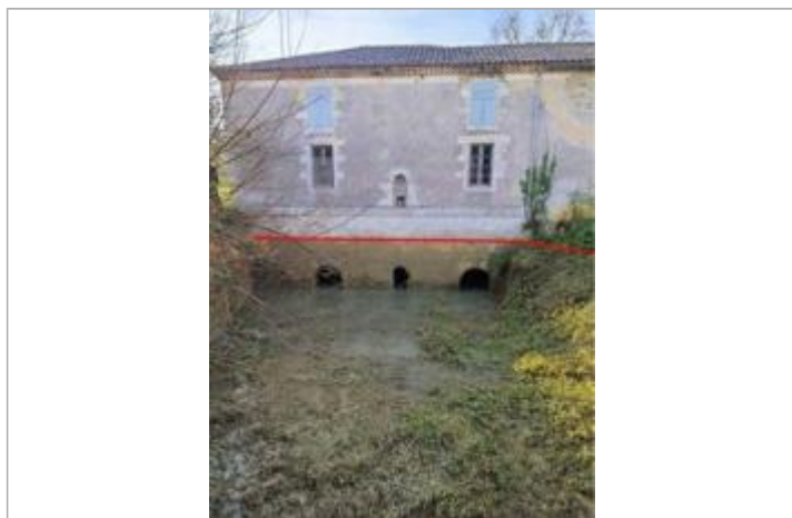
Vue du repère - Photo ©AGERIN
