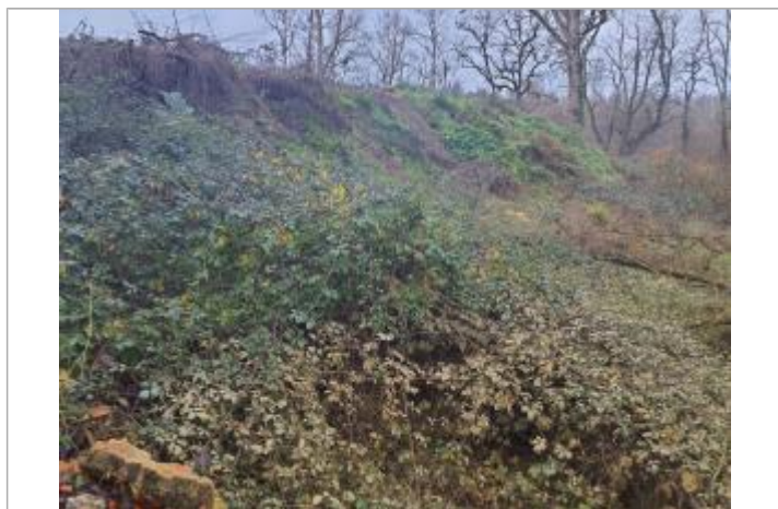
Vue du repère - Photo ©AGERIN
