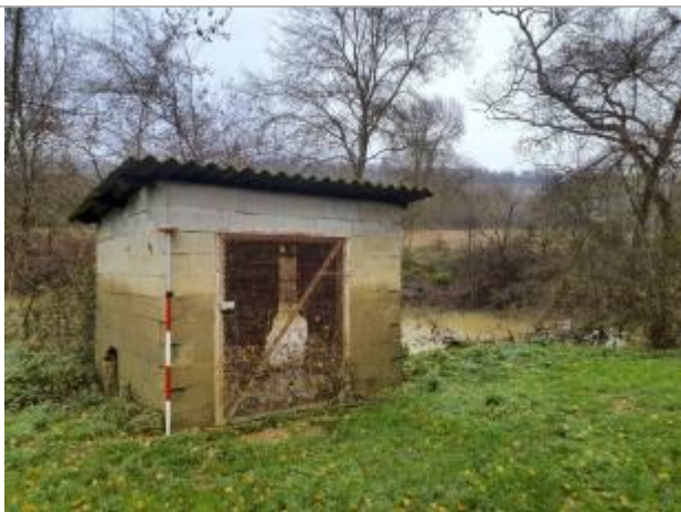
Vue du repère - Photo ©AGERIN
