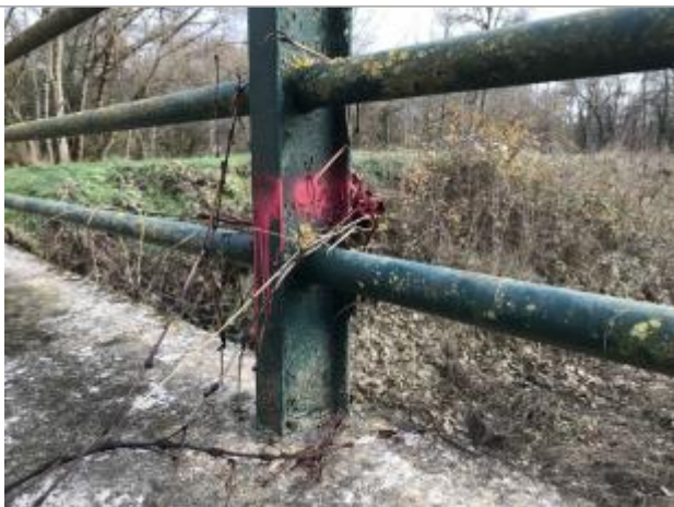
Vue du repère - Photo ©AGERIN
