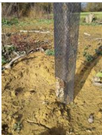
Vue du repère - Photo ©AGERIN
