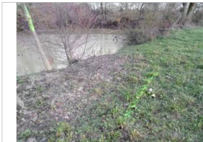
Vue du repère - Photo ©AGERIN
