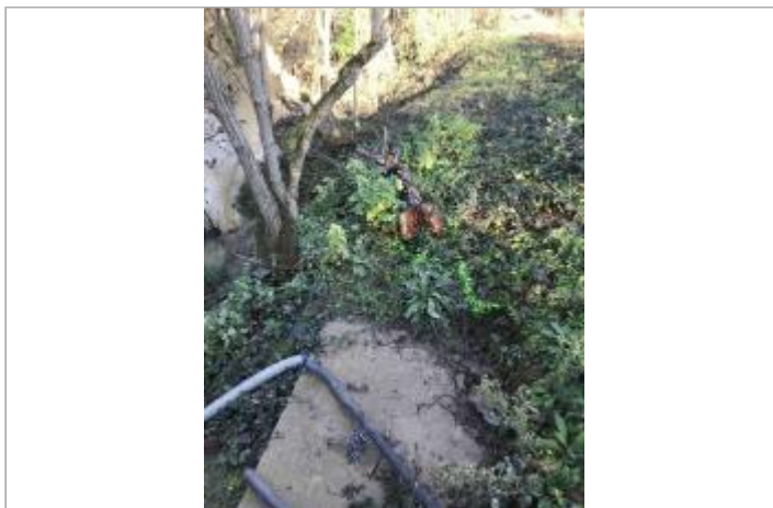
Vue du site - Photo ©AGERIN
