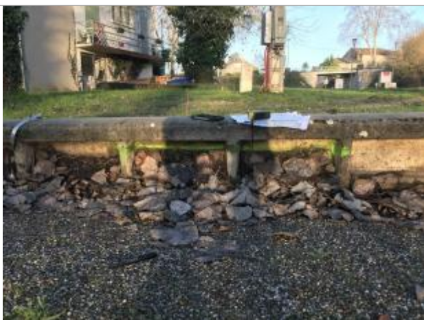
Vue du repère - Photo ©AGERIN
