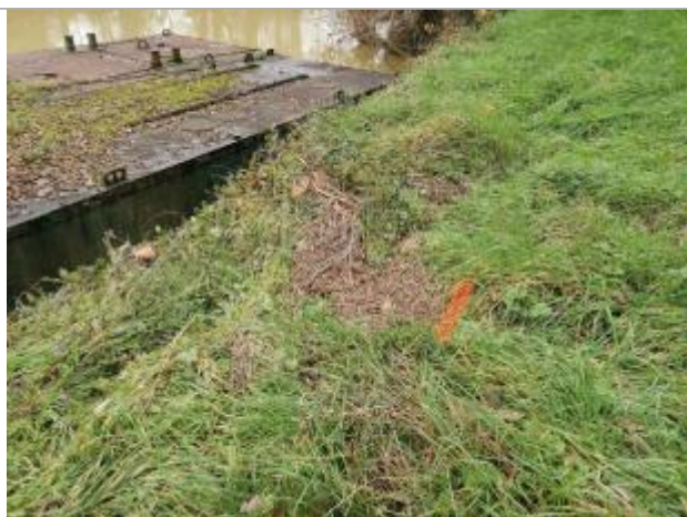
Vue du repère - Photo ©AGERIN
