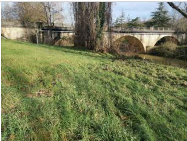
Vue du repère - Photo ©AGERIN
