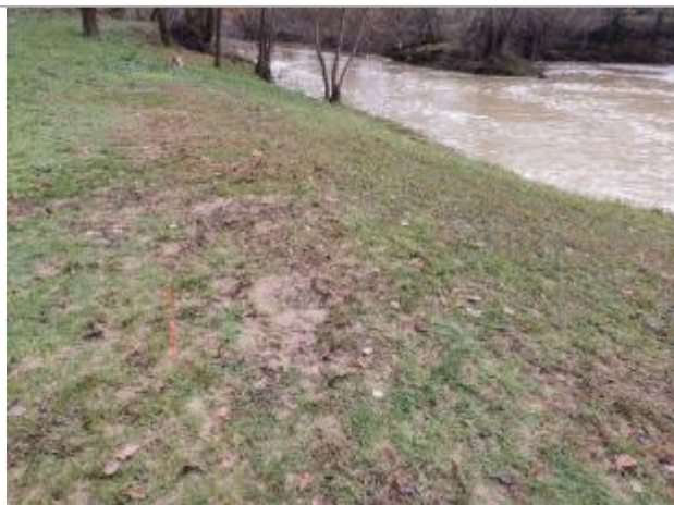
Vue du repère - Photo ©AGERIN
