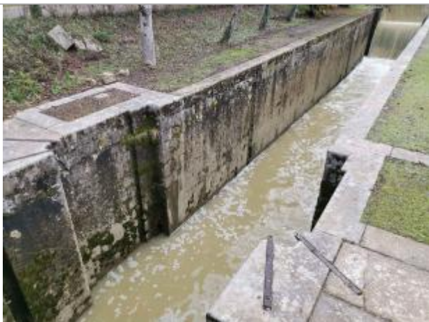
Vue du repère - Photo ©AGERIN
