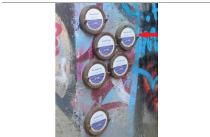
Repère normalisé de l'inondation du 29 décembre 1999
