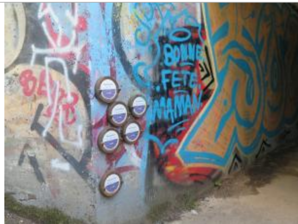
Entrée du passage sous le pont de la rue Saint Malo
