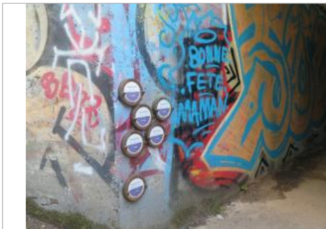
Entrée du passage sous le pont de la rue Saint Malo
