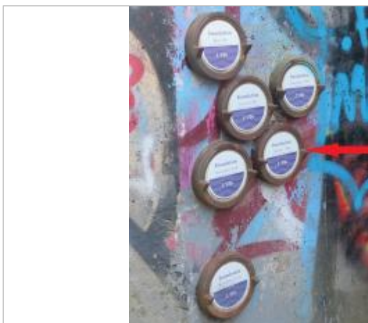
Repère normalisé de l'inondation du 24 octobre 1966
