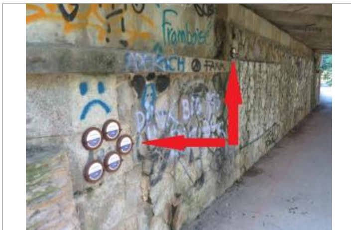
Sous le pont de la rue Papu
