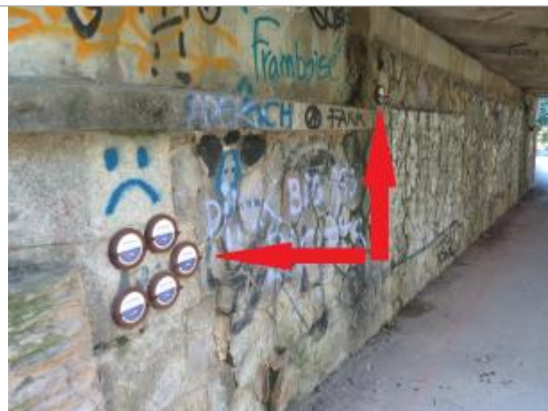
Sous le pont de la rue Papu
