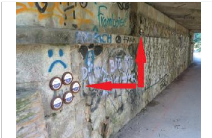
Sous le pont de la rue Papu
