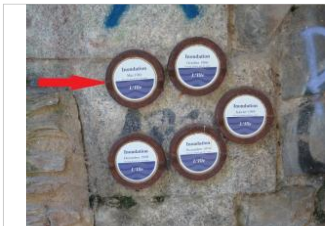
Repère normalisé de l'inondation du 14 Mai 1981
