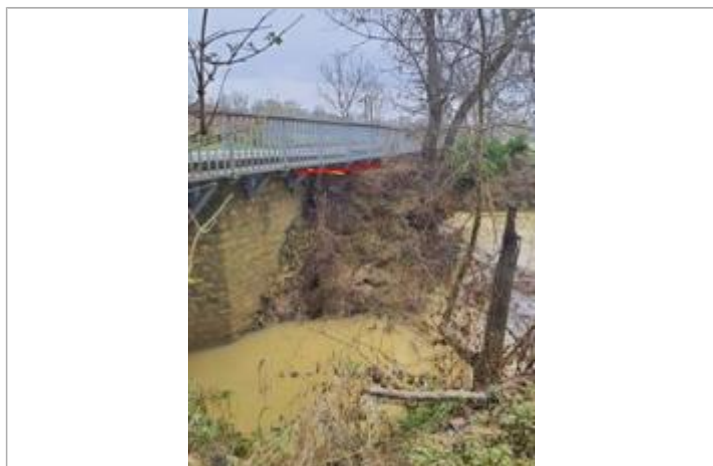
Vue du repère - Photo ©AGERIN
