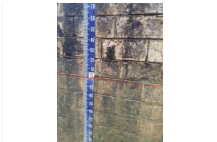
Vue du repère - Photo ©AGERIN
