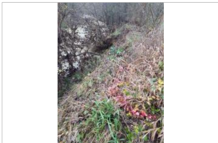
Vue du repère - Photo ©AGERIN
