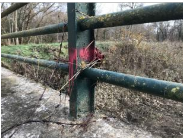
Vue du repère - Photo ©AGERIN
