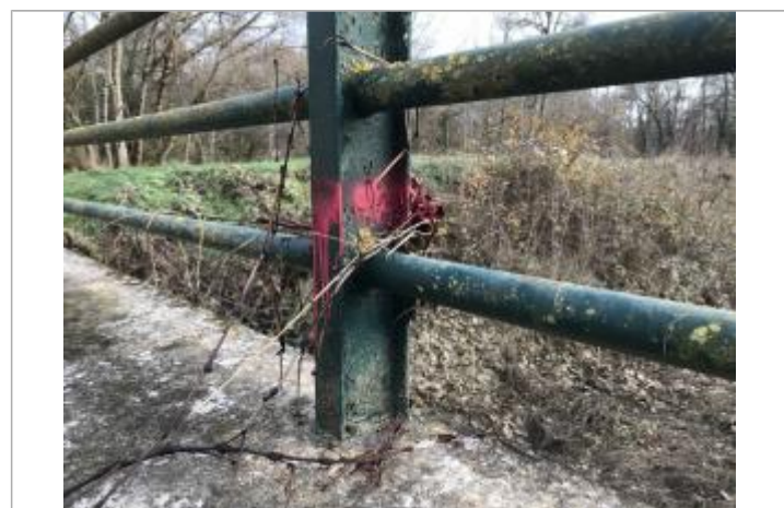
Vue du repère - Photo ©AGERIN
