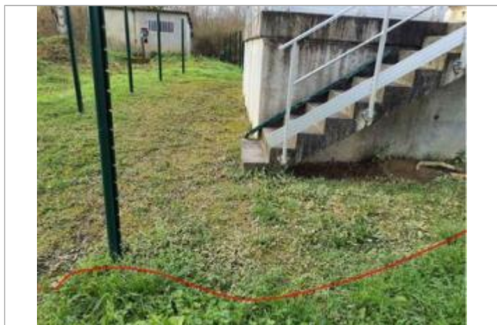
Vue du repère - Photo ©AGERIN
