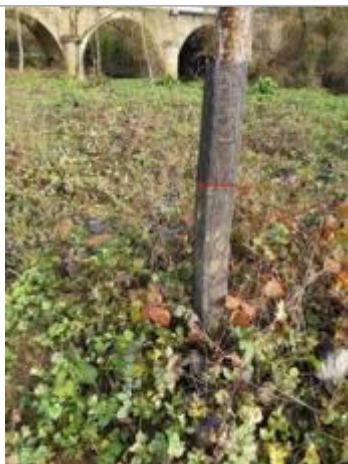
Vue du repère - Photo ©AGERIN
