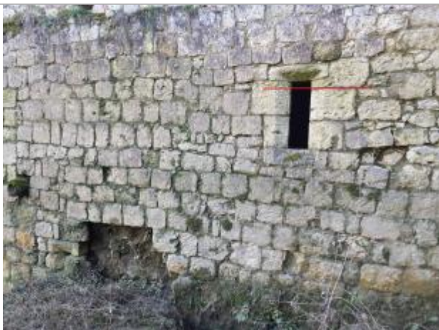
Vue du repère - Photo ©AGERIN
