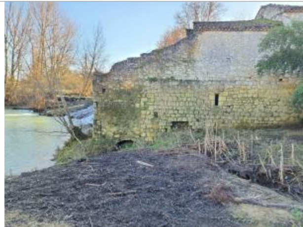
Vue du site - Photo ©AGERIN
