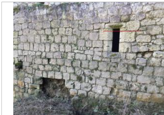
Vue du repère - Photo ©AGERIN
