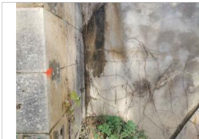
Vue du repère - Photo ©AGERIN
