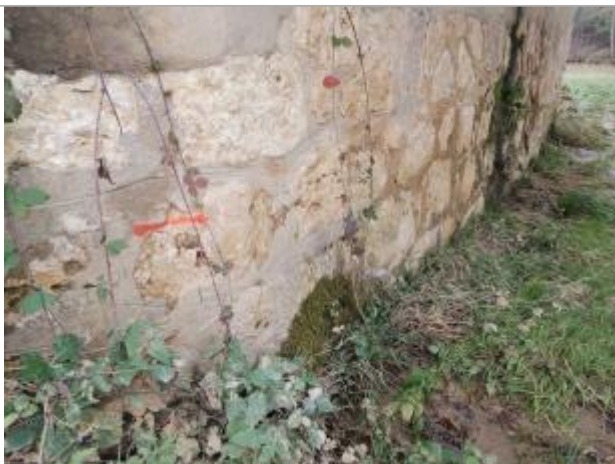
Vue du repère - Photo ©AGERIN
